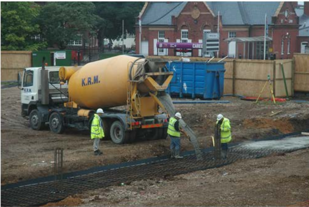
Pouring concrete
